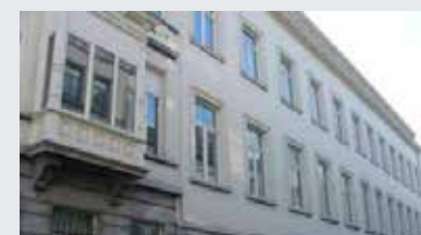
Drapiers Ensemble immobilier situé rue des Drapiers à Bruxelles.
